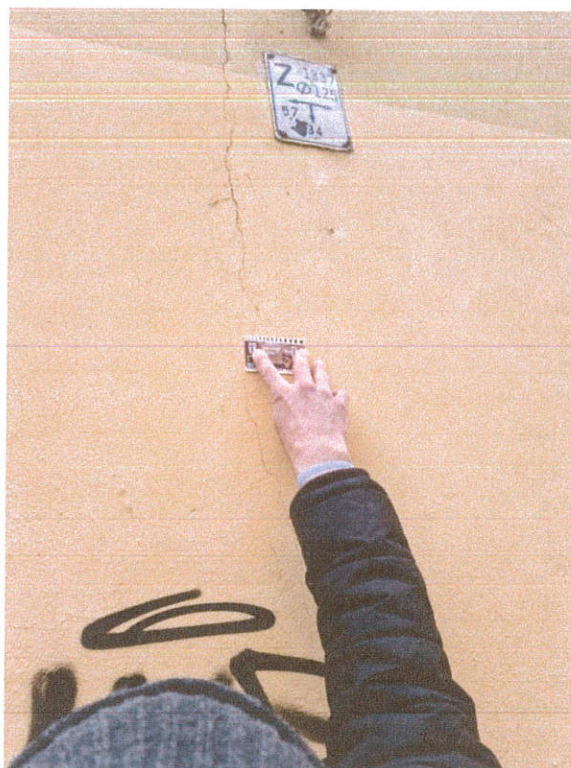
Fot. 23 Duże (1 mm) rozwarcie rysy przy narożniku budynku od ul. Kazimierza Wielkiego – widoczne obok zaistniałej rysy sklejenie powierzchniowe (zatarcie) wcześniejszego zarysowania (bez iniekcji muru)
