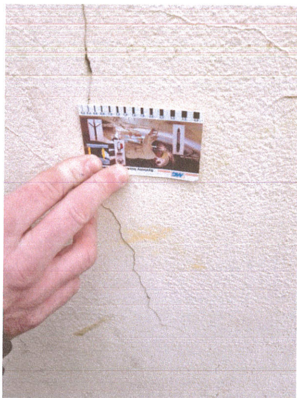
Fot. 19 - 20 Pomiary rozwartości rys na elewacji od ul. Kazimierza Wielkiego
