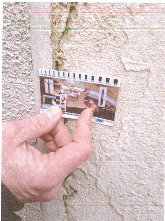
Fot. 23 Duże (1 mm) rozwarcie rysy przy narożniku budynku od ul. Kazimierza Wielkiego – widoczne obok zaistniałej rysy sklejenie powierzchniowe (zatarcie) wcześniejszego zarysowania (bez iniekcji muru)
