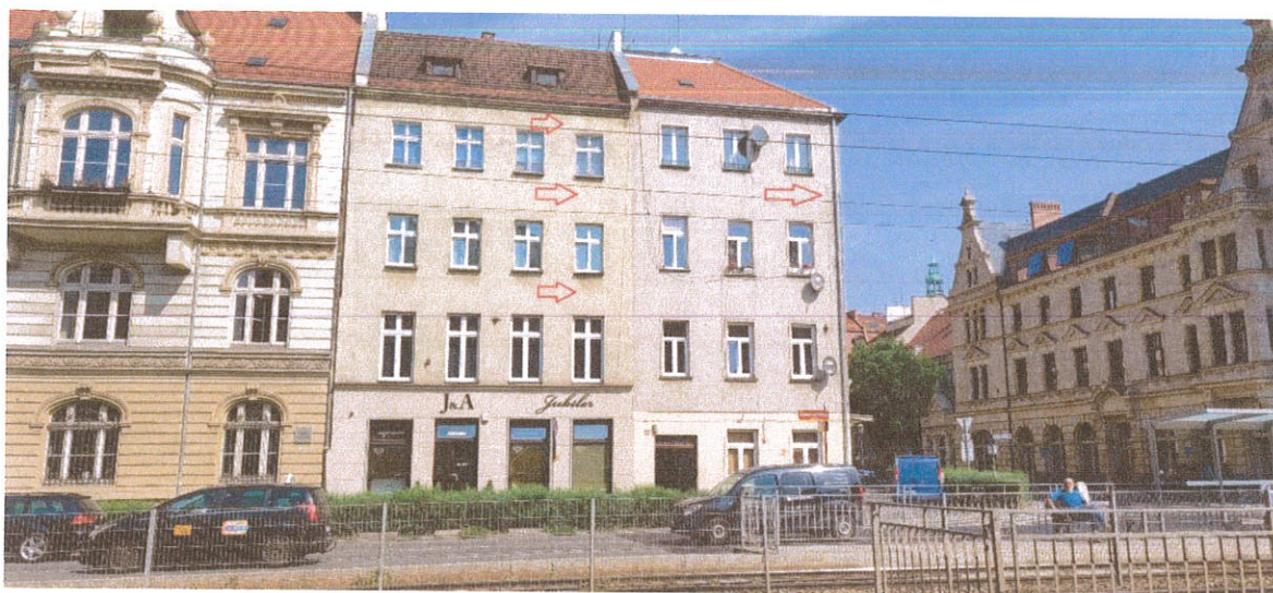
Fot. 1 Widok elewacji południowej budynku od ul. Kazimierza Wielkiego
